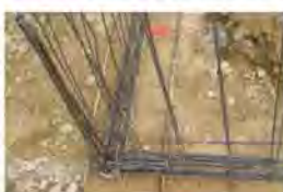
Nœud de chaînage - Continuité mécanique
