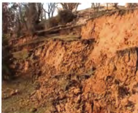
Niche d'arrachement © France 3
