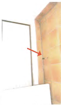
Affaisssement du plancher mis en évidence par le décollement entre plinthes et dallage - Maison Jourdan.
